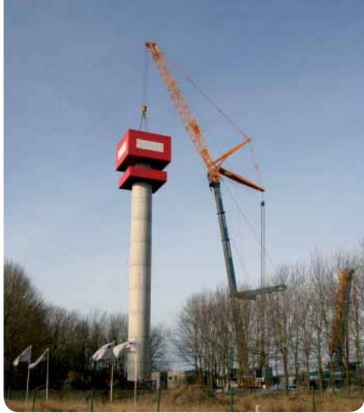
Afbeelding.1.4 : Foto van de bouw van de radartoren te Jabbeke
