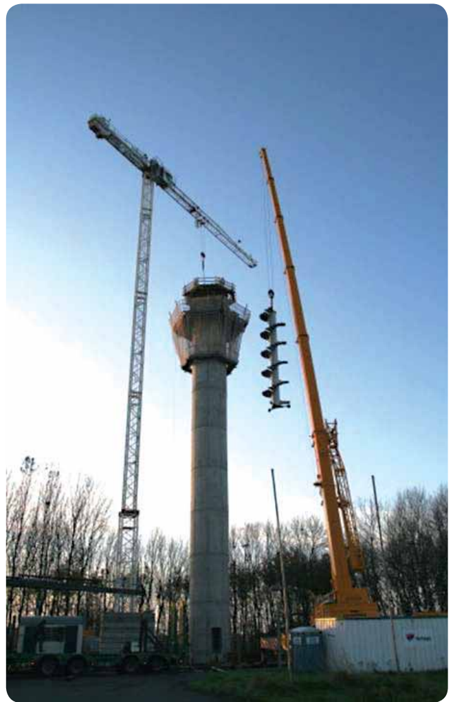
Abbeelding 4.1 : Bouw van de weertoren in Jabbeke : Plaatsing van de wenteltrap op 19 december 2008.
